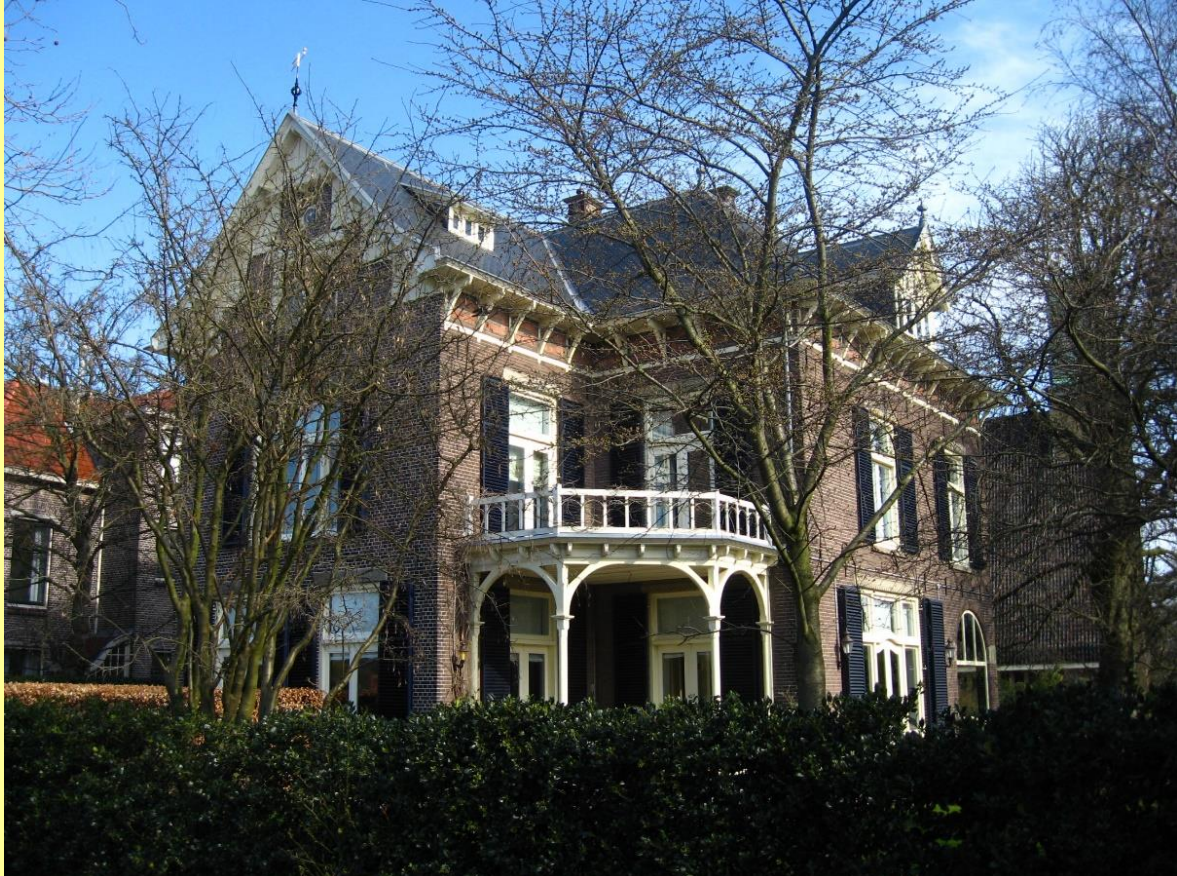
De woning van de dames Drost aan de Leidsestraatweg 16 te Oegstgeest Bron: www.monumenten.nl/monument/515007
